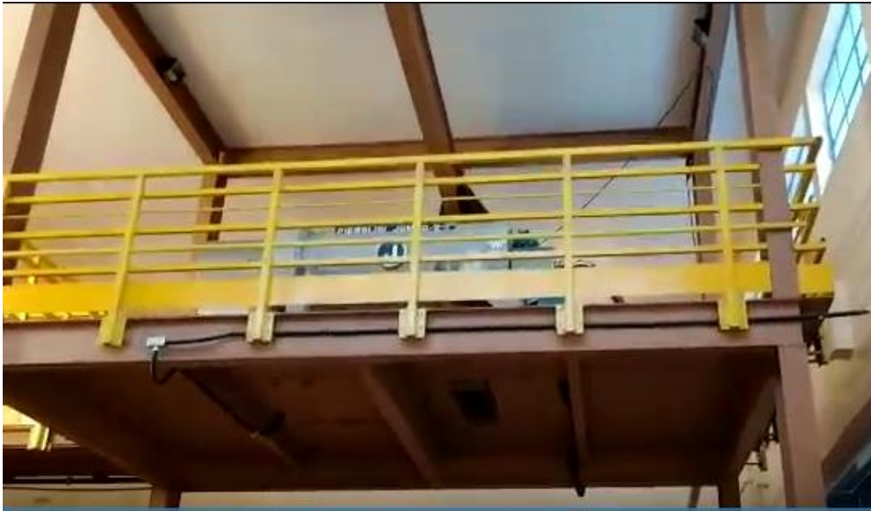
Figura 8- Unidade de Tratamento de Lodo por Centrifugação. Fonte: Vigiagua, 2018.
