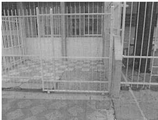
Figura 52 – Da existência de rampa para acessibilidade dos PND.
