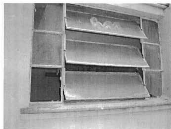
Figura 24 – Balsa da sala do transformador danificada e com os vidros quebrados.
