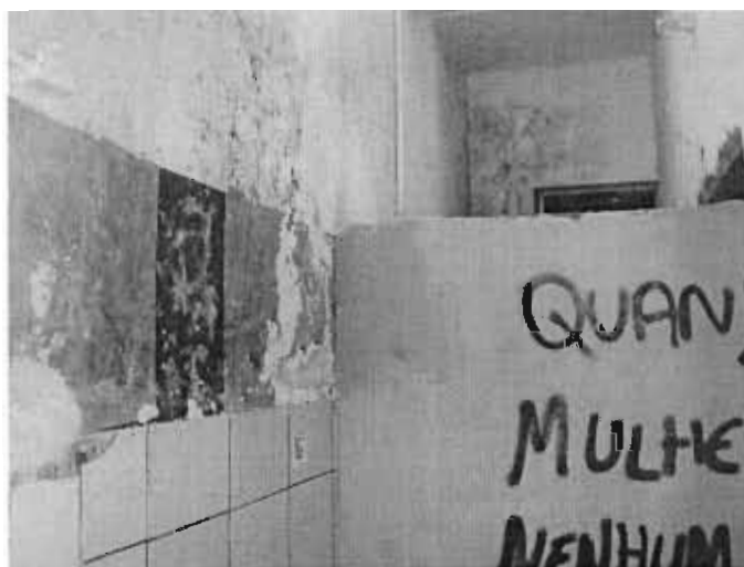
Figura 28 – Parede divisória dos banheiros masculino e feminino, existentes na catacumba.
